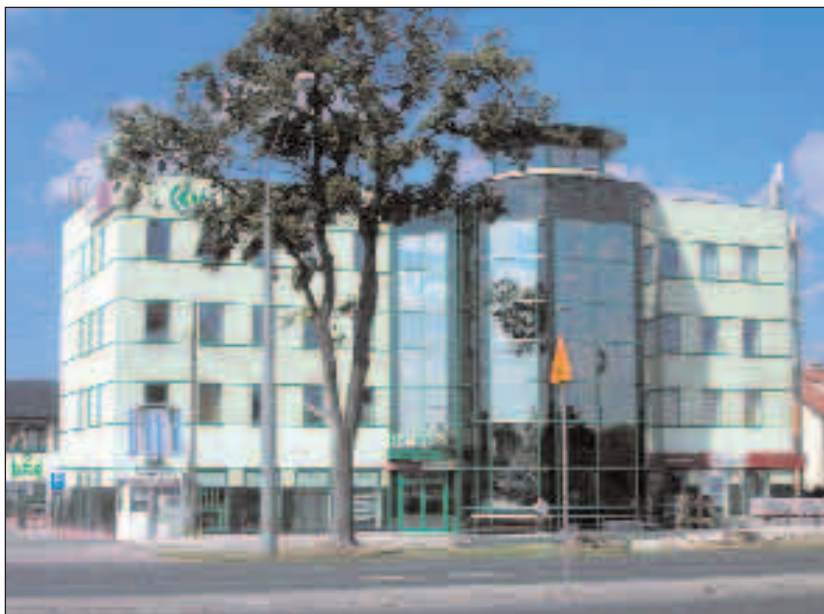
Fot. Nova 2 Solaria
